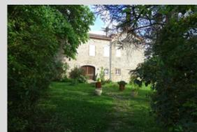
Les volumes : les bâtiments possèdent un rapport toiture/façade de 1/3 (toiture) 2/3 (façade). La hauteur de façade est généralement comprise entre 6 et 8 mètres. Cela représente une typologie constructive de type R+1+combles.
